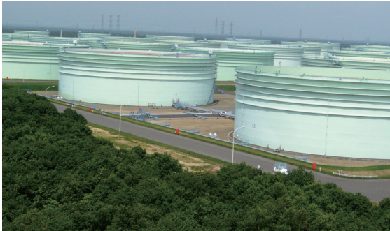
苫東石油備蓄(株)
