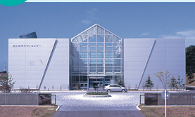
苫小牧市テクノセンター
