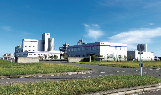
オエノングループ合同酒精 (株) 苫小牧工場
